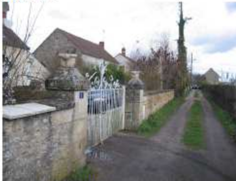
Portail et mur en pierre
