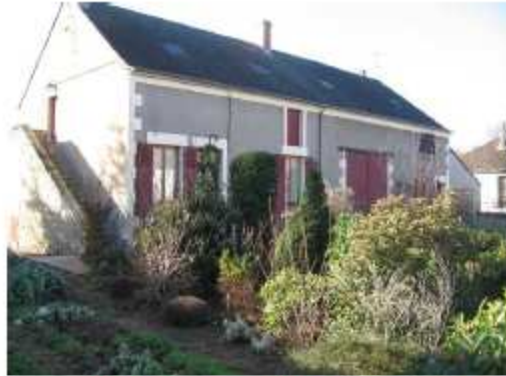
Maison bloc du faubourg de la Baratte de 1850 au début 1900 pierre, chaux, ardoises
